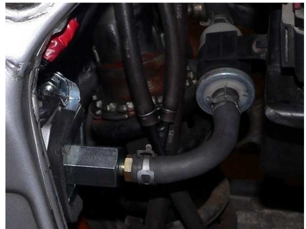
Réutiliser la durite existante entre le filtre à essence et la pompe d'origine.
